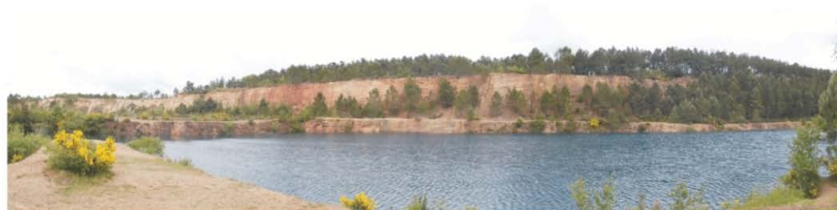
2 - Vue sur le fond de fouille en eau
